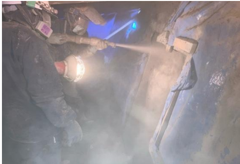
吹付け（横向き）
