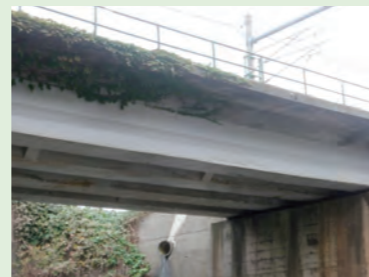
写真1 海岸沿いの橋梁の桁
