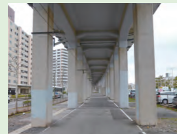
写真2 海岸に近い高架橋の橋脚
