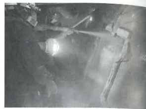
写真-2 SSI工法乾式吹付け
