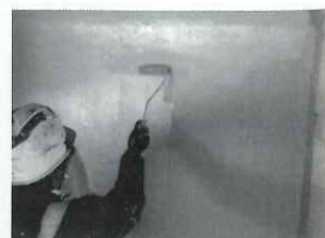
写真-3 シリコンガード施工状況
